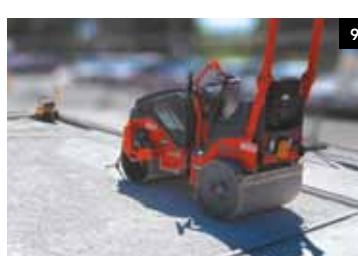
**9 Stendere e compattare uno strato di stabilizzato con spessore 10cm.**
