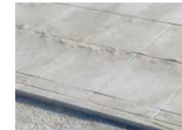
**16 Completare il riempimento delle fughe.**
