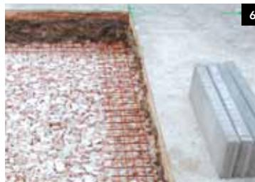
**6 Stendere lungo il perimetro una rete metallica per ancoraggio del cordolo.**
